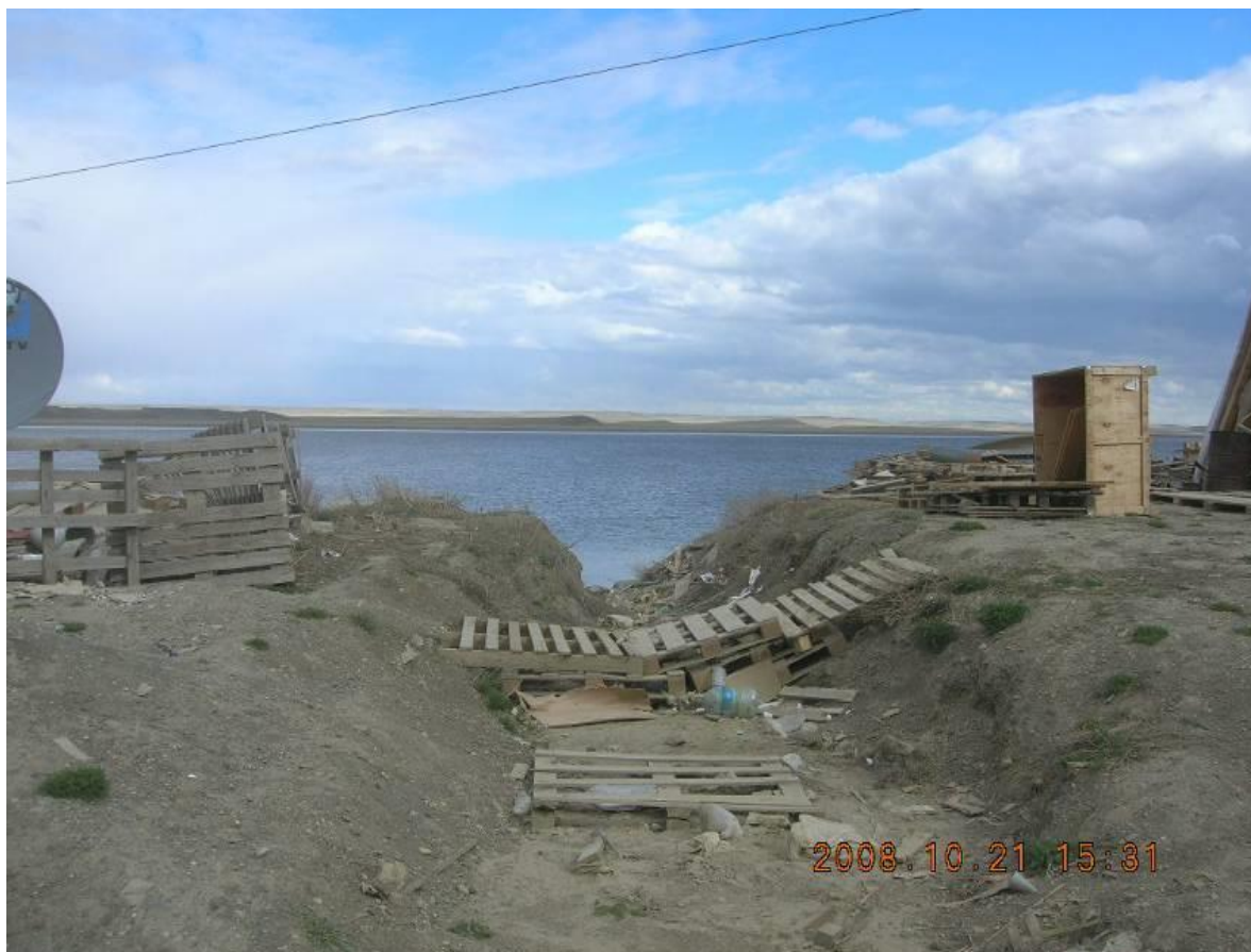
Fig 12. Oct/ 2008-Sector calle Sarmiento estado de los desagües al río. Pto 10
